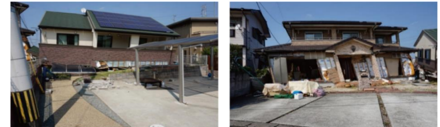
※写真左：2010年建築の住宅(耐震等級2) 写真右：2007年建築の住宅(耐震等級1)
